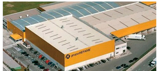
Auditoría Energética instalaciones para cumplimiento RD 56/2016 (HEFAME)
